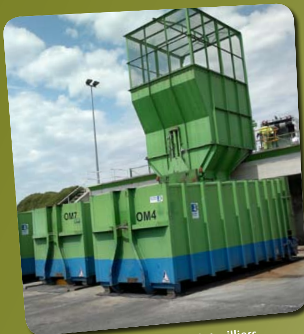
Quai de transfert à Argilliers
