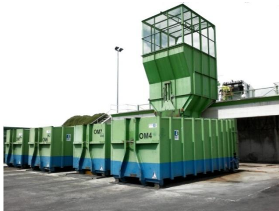
Quai de transfert d'Argilliers
