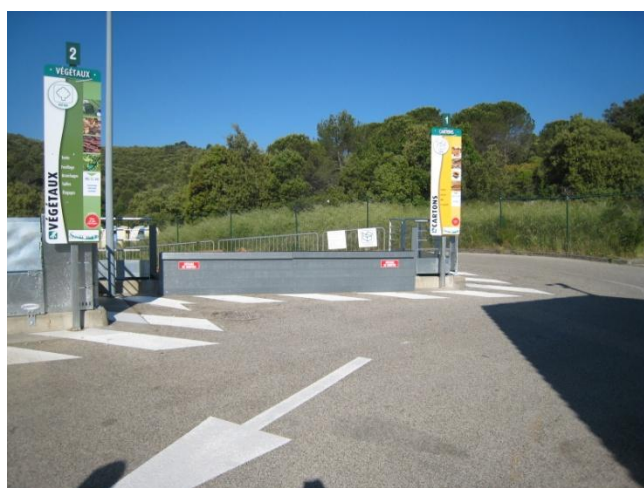
Déchèterie de Lussan après réhabilitation
