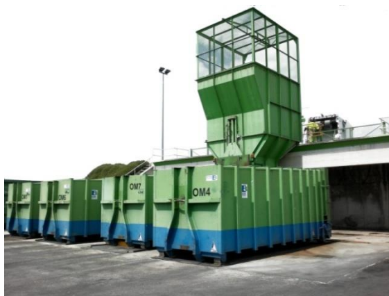
Quai de transfert d'Argilliers
