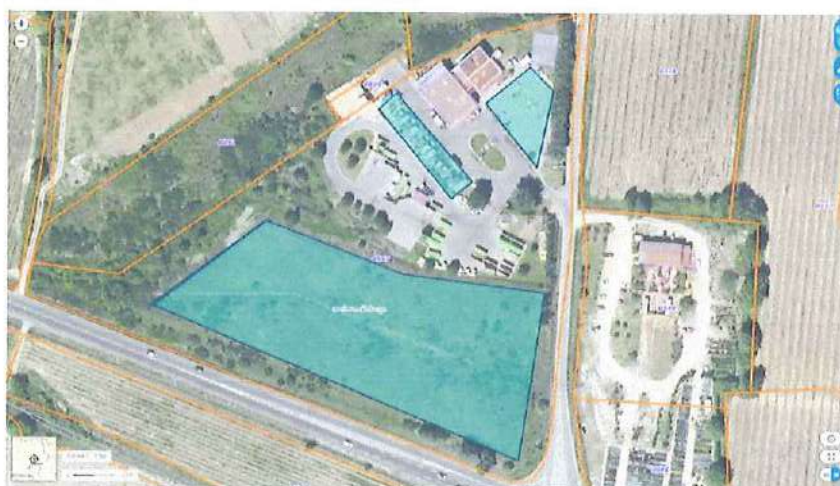
Vue aérienne du site d'Argilliers – Quartier Bord Nègre Zone des emprises photovoltaïque
